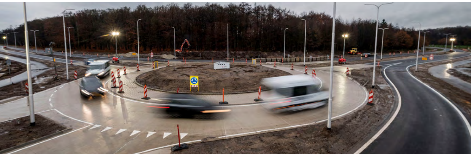
De Motis rotonde, gekoppeld aan de innovatieroute N737 in Twente. Dankzij geluidsdetectie weet de weg waar verkeersgebruikers zijn. De weg past zich daaraan aan. Verkeerslichten gaan langer op groen als er verkeer aanstaande is, hulpdiensten kunnen worden gealarmeerd als een ongeval plaatsvindt.
